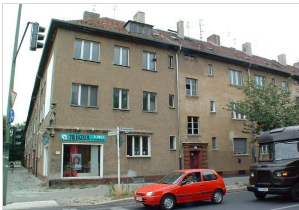
Eckgebäude Hosemannstraße/Ostseestraße vor der Sanierung Fotos: Am Ostseeplatz eG.
